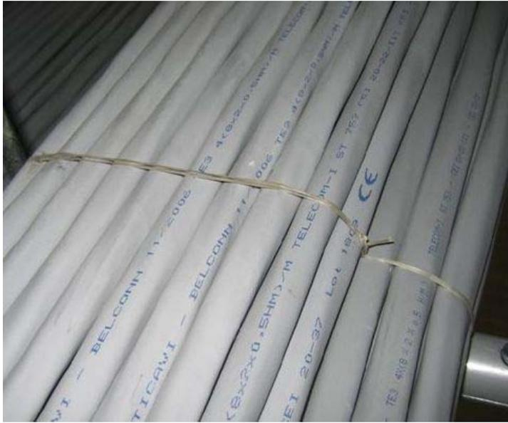
**Figura 31 Dettaglio di legatura a “Fascio”**
