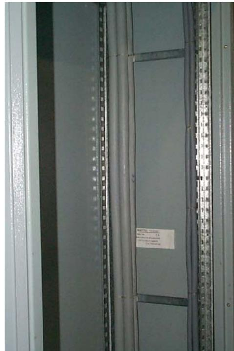
**Figura 32 Legatura a “Fascio” interna alle fiancate del telaio**
