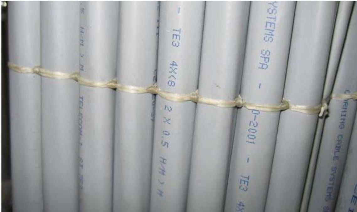
*Figura 34 Dettaglio di legatura a “Pacco”*
