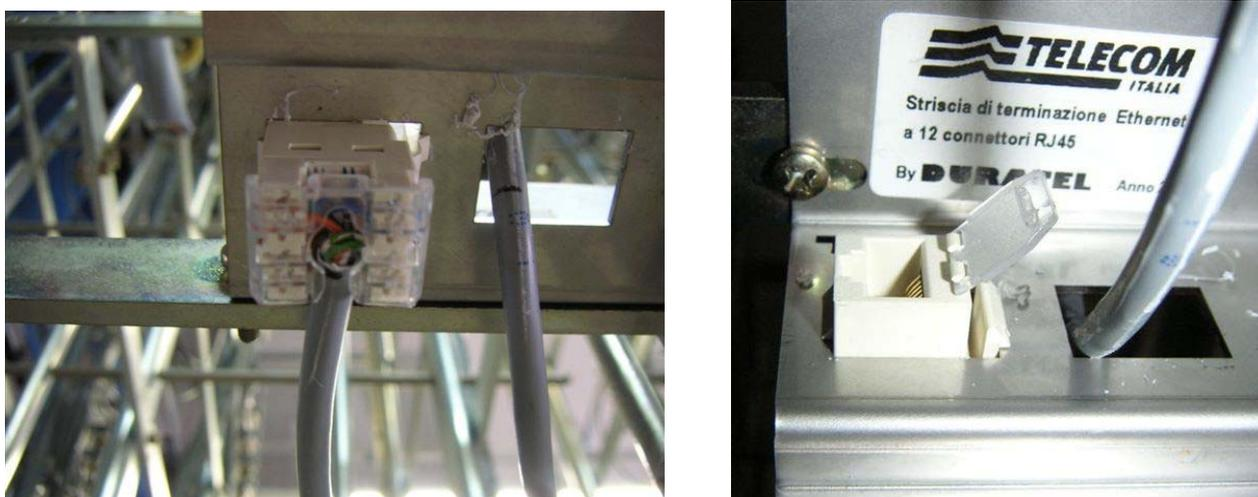
**Figura 64 – montaggio connettore su supporto striscia**
