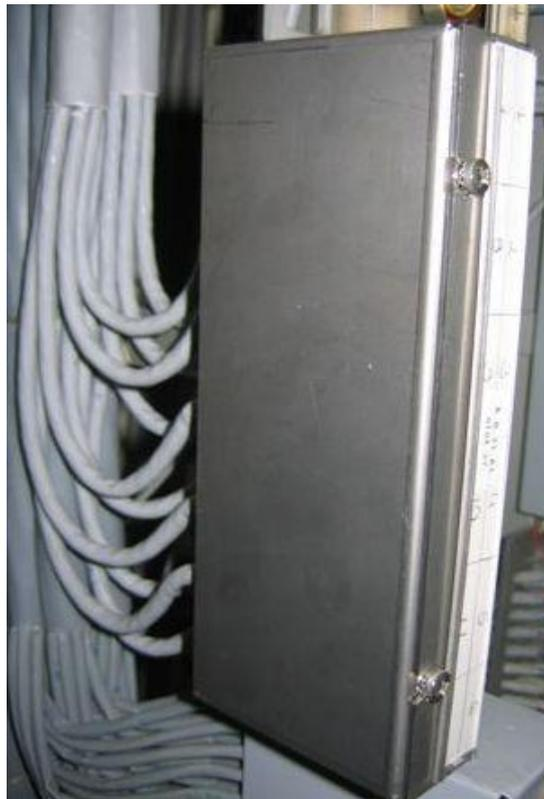
***Figura 59 – Esempio di sagomatura cavi sul lato verticale***
