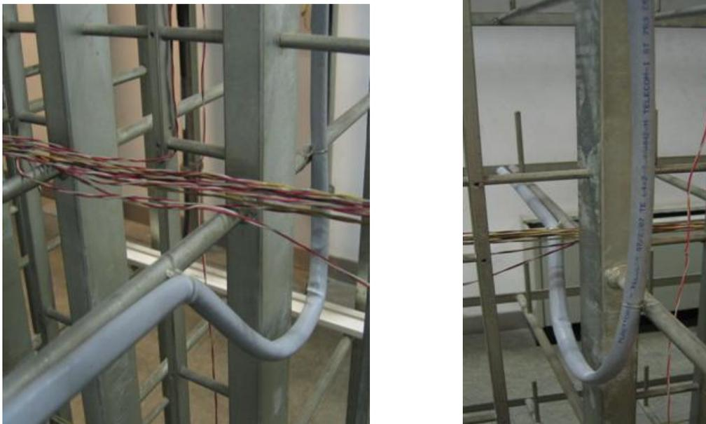
*Figura 41 – Ricchezza del cavo sulla discesa al PU*
