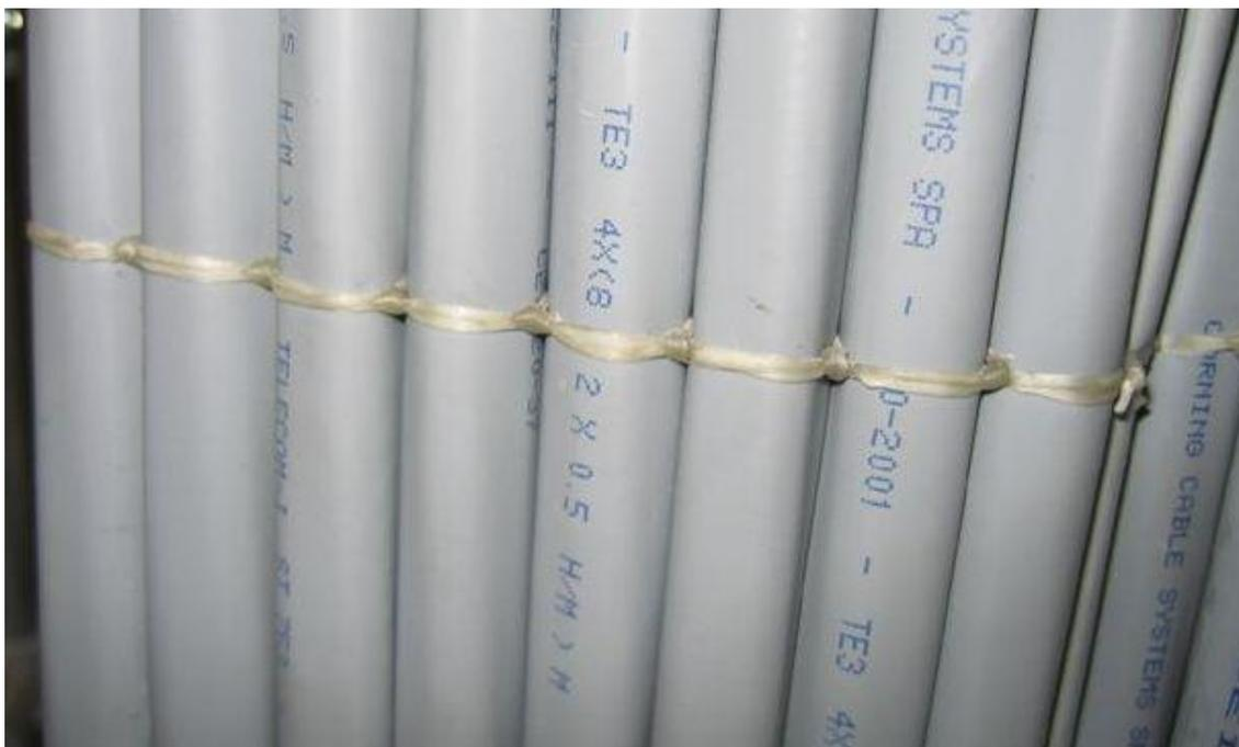
**Figura 34 – Dettaglio di legatura a “Pacco”**
