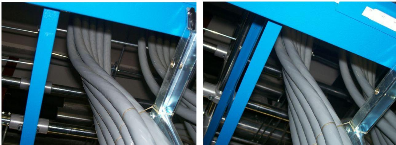
**Figura 25 – Esempio di posa dei cavi ad elica**
