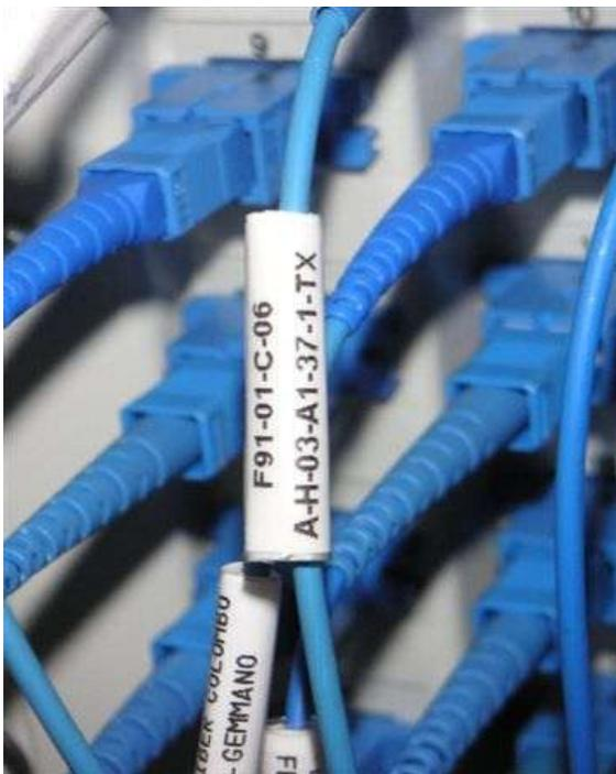
Esempio di Collegamento Rip. Ottico – Apparato
