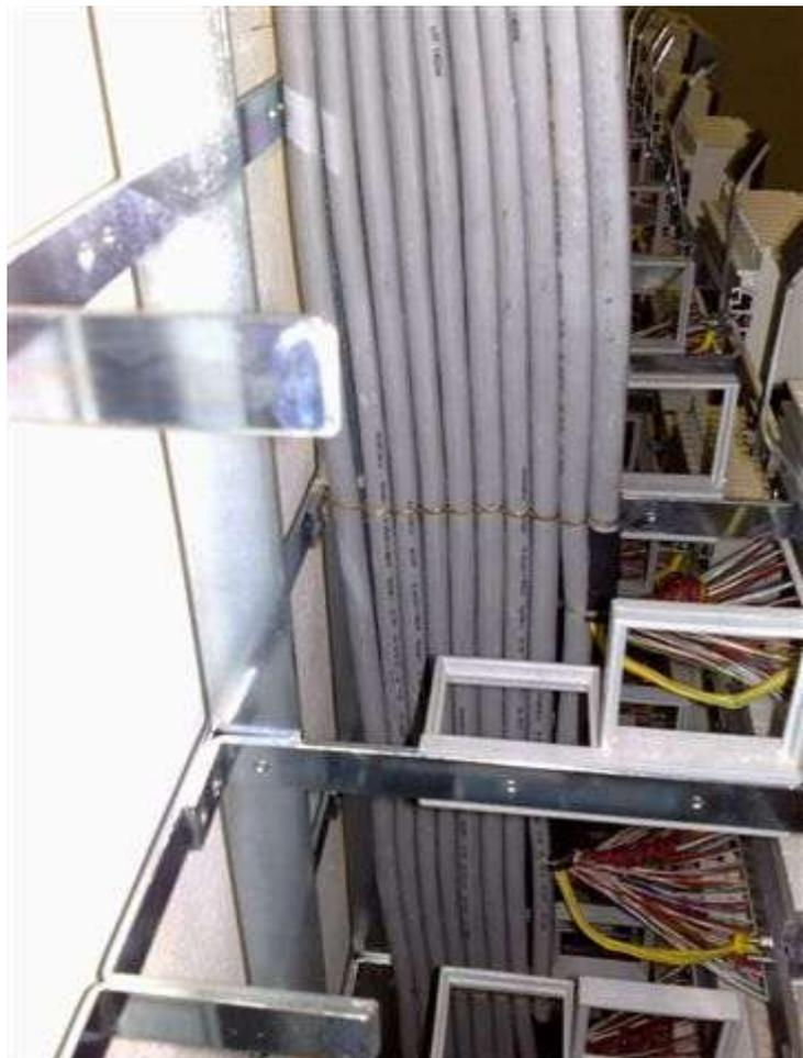
**Figura 37 – Esempio di posa su Ripartitore monofronte con un unico strato di cavi per tutti i livelli**
