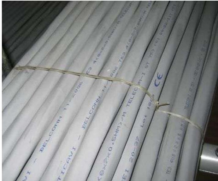
**Figura 31 – Dettaglio di legatura a “Fascio”**
