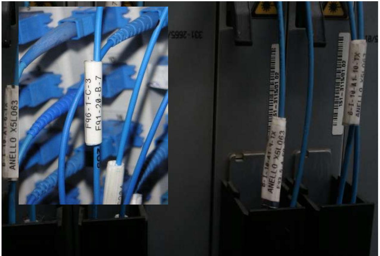
**Figura 71 – Modalità di Etichettatura delle bretelle F.O.**
