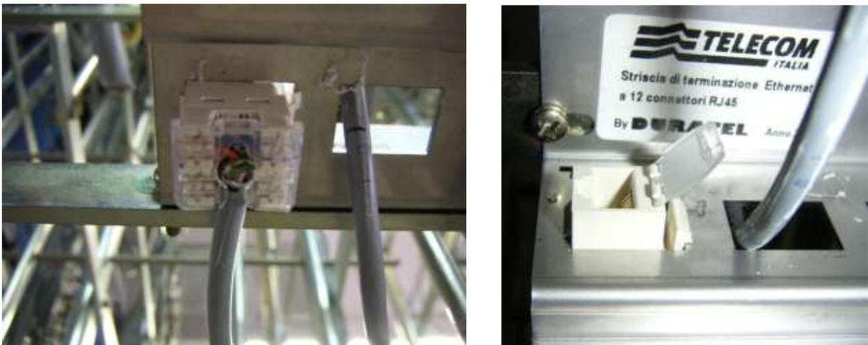
**Figura 64 – montaggio connettore su supporto striscia**
