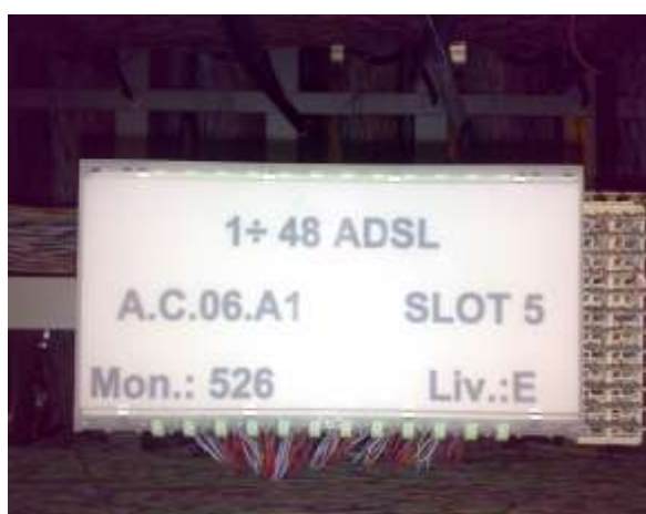
Figura 69: Esempio di cartellini striscia per attestazione ADSL
