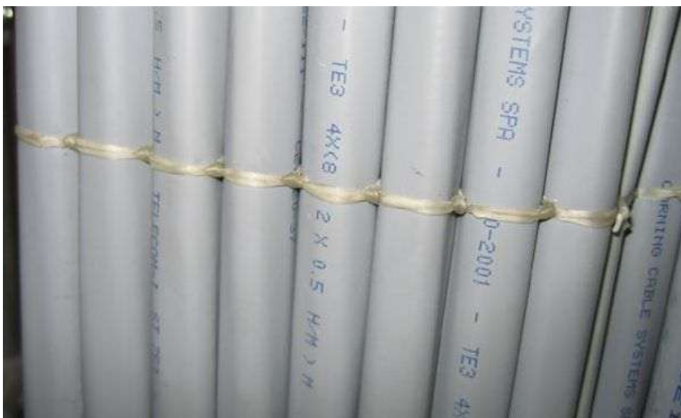
Figura 34: Dettaglio di legatura a “Pacco”
