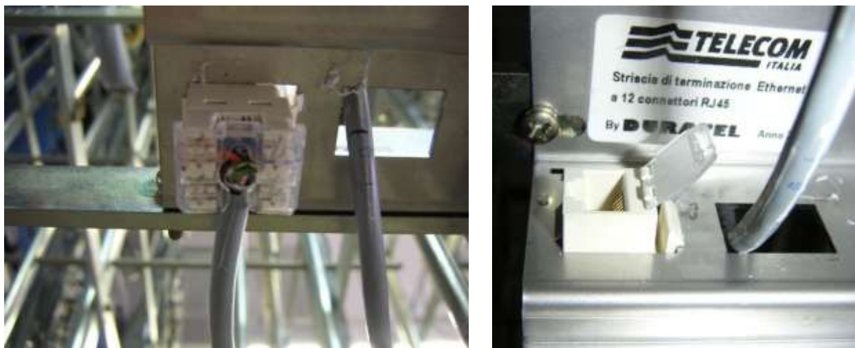
Figura 64: Montaggio connettore su supporto striscia
