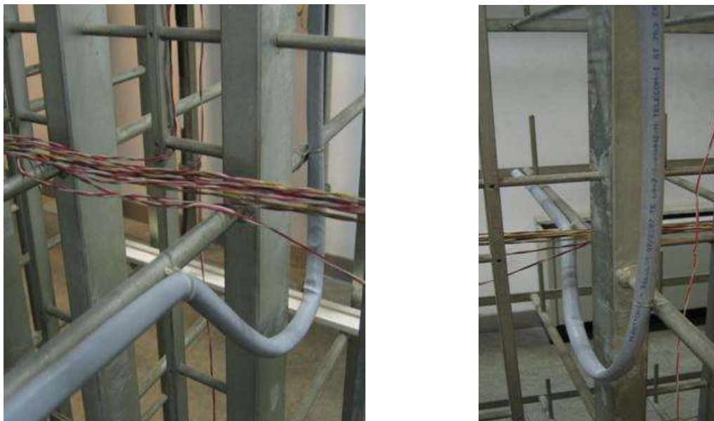
Figura 41: Ricchezza del cavo sulla discesa al PU
