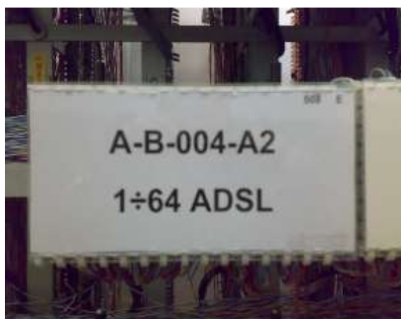
Figura 69: Esempio di cartellini striscia per attestazione ADSL
