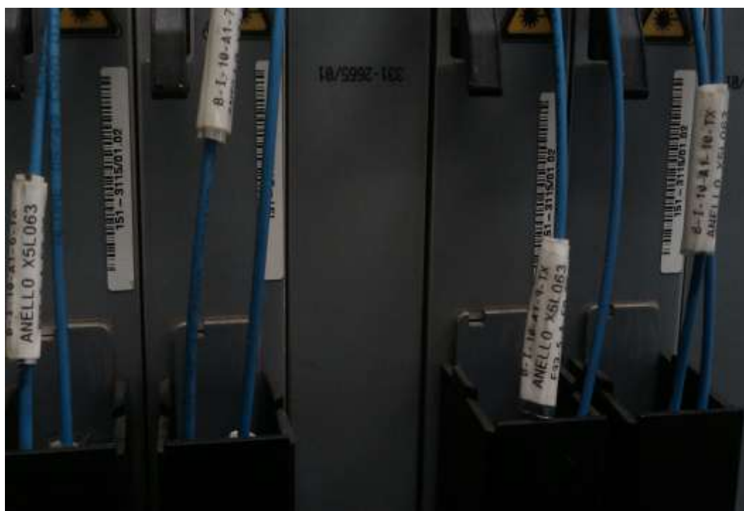
Figura 71: Modalità di Etichettatura delle bretelle F.O.
