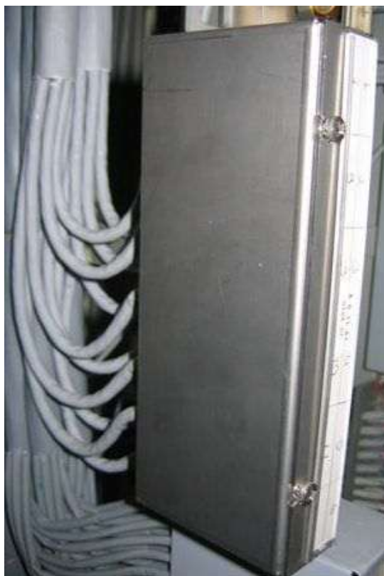
Figura 59: Esempio di sagomatura cavi sul lato verticale
