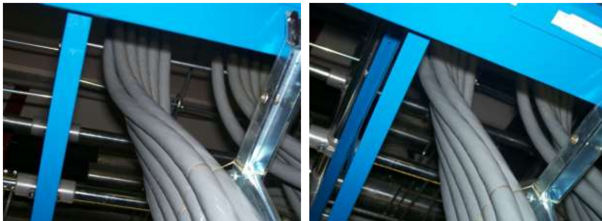
Figura 25: Esempio di posa dei cavi ad elica
