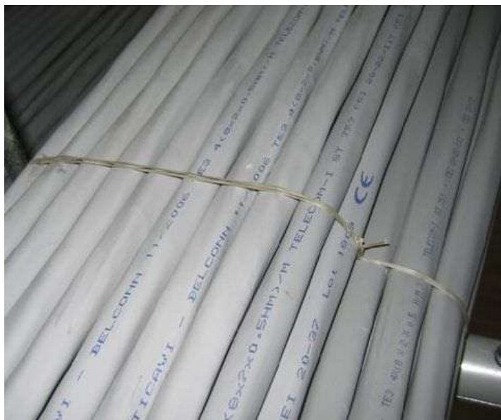
Figura 31: Dettaglio di legatura a “Fascio”
