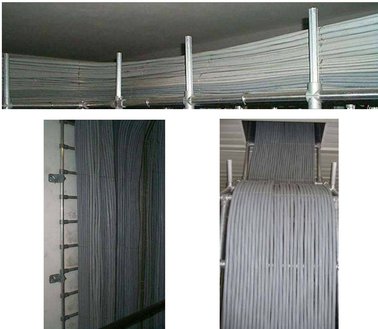
Figura 24: Esempio di posa orizzontale e verticale con pacco cavi omogeneo e compatto
