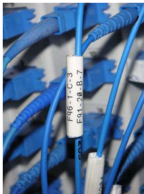
Esempio di Collegamento Rip. Ottico – Rip. Ottico
