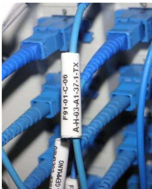
Esempio di Collegamento Rip. Ottico – Apparato
