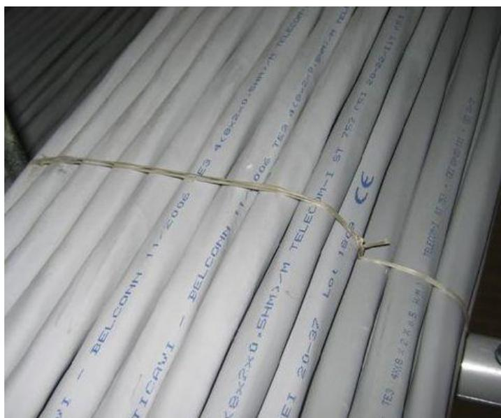
**Figura 31: Dettaglio di legatura a “Fascio”**
