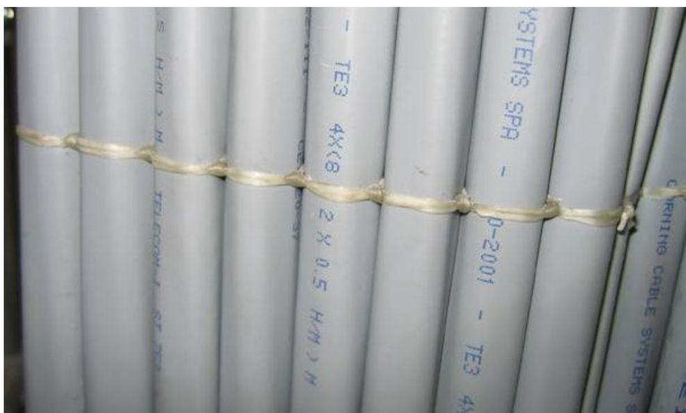
**Figura 34: Dettaglio di legatura a “Pacco”**
