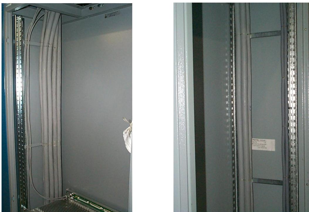
**Figura 32: Legatura a “Fascio” interna alle fiancate del telaio**
