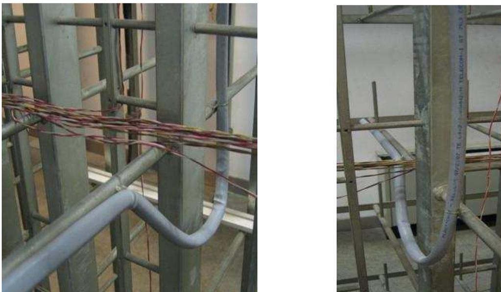
**Figura 41: Ricchezza del cavo sulla discesa al PU**
