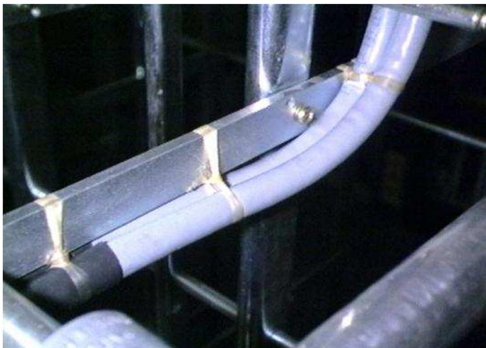
**Figura 40: Esempio di legatura dei cavi BF sul lato orizzontale del Ripartitore Doppio Fronte in prossimità della striscia di terminazione**
