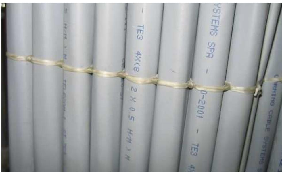
**Figura 34: Dettaglio di legatura a “Pacco”**
