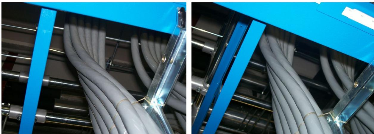
**Figura 25: Esempio di posa dei cavi ad elica**
