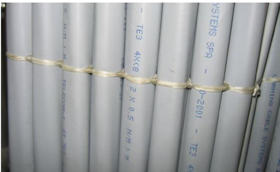
**Figura 34: Dettaglio di legatura a “Pacco”**
