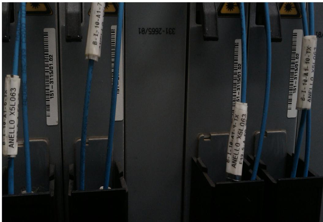
Figura 71: Modalità di Etichettatura delle bretelle F.O.
