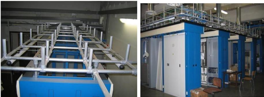
Figura 3 Planare tubolare da 35 mm ad un livello e a due livelli
