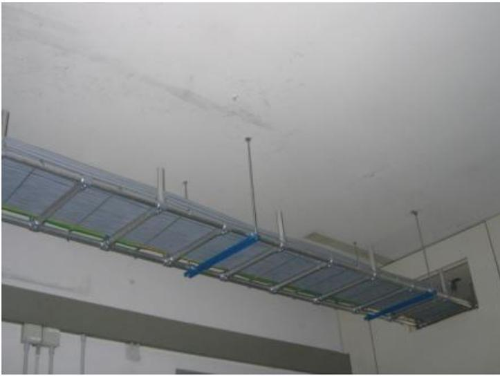
Figura 4 Passatoia Doppia aperta Tubolare Orizzontale diametro 35mm
