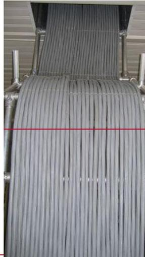
Figura ~~24:21~~ Esempio di posa orizzontale e verticale con pacco cavi omogeneo e compatto
