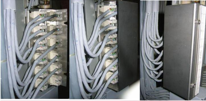
Figura 60 – Esempio di sagomatura cavi sul lato verticale
