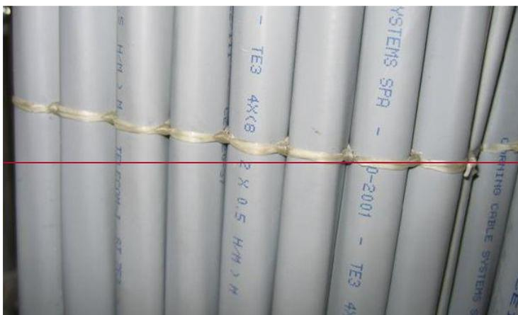
Figura ~~34:31~~ Dettaglio di legatura a "Pacco"
