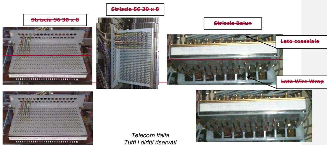
Figura ~~55-57~~ – Esempi di Strisce che utilizzano la connessione avvolta WW
