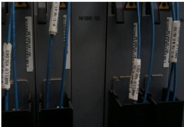
Figura ~~74:~~108 – Modalità di Etichettatura delle bretelle F.O.
