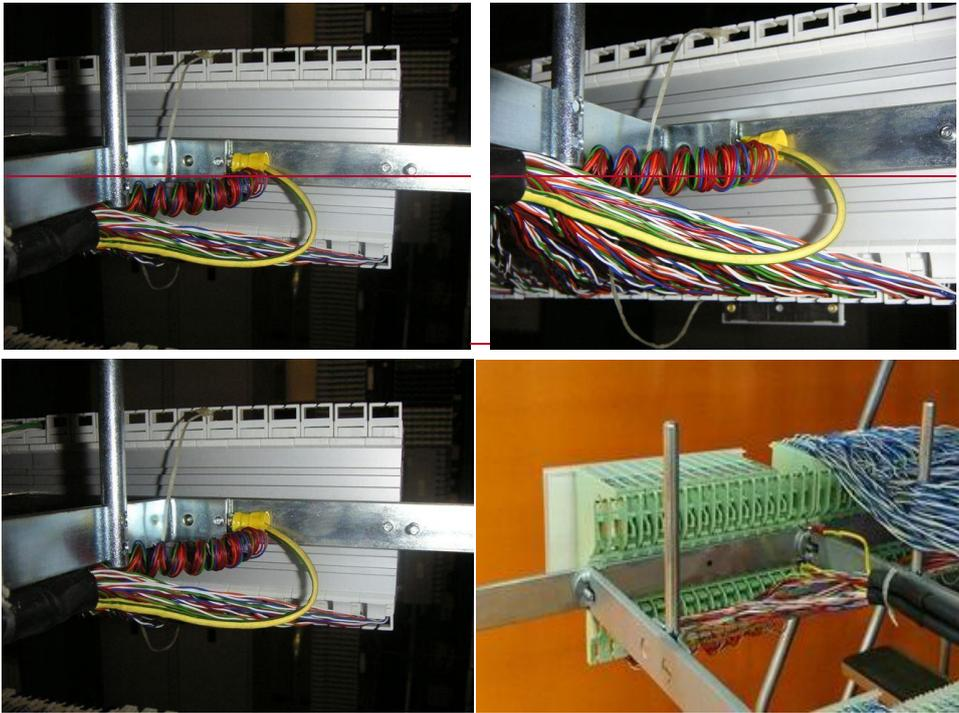
Figura 42: ~~Coppie~~43 – A sinistra coppie di scorta avvolte in un'unica spiralina dietro la striscia IDC per cablaggi OLO. A destra vista posteriore della striscia ADSL al Permutatore
