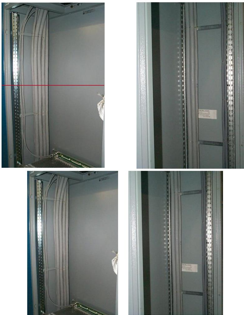
Figura ~~32~~:29 Legatura a “Fascio” interna alle fiancate del telaio
