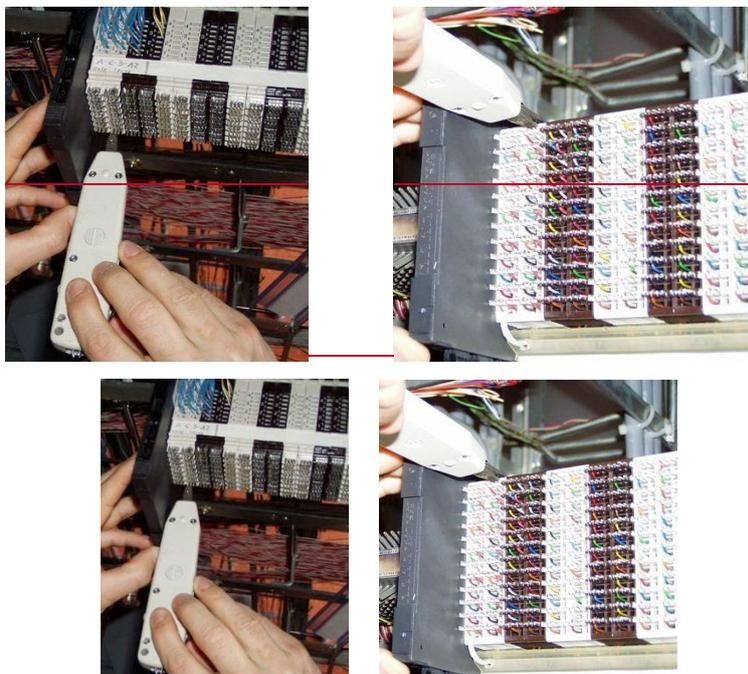
Figura ~~45~~47 – Esempio di striscia IDC
