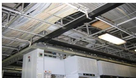
Figura 16 Canalina F.O. Interfila/Lungofila
