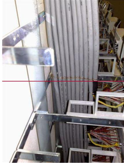
Figura ~~37:~~34 Esempio di posa su Ripartitore monofronte con un unico strato di cavi per tutti i livelli
