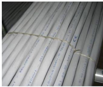
Figura ~~34:28~~ Dettaglio di legatura a "Fascio"
