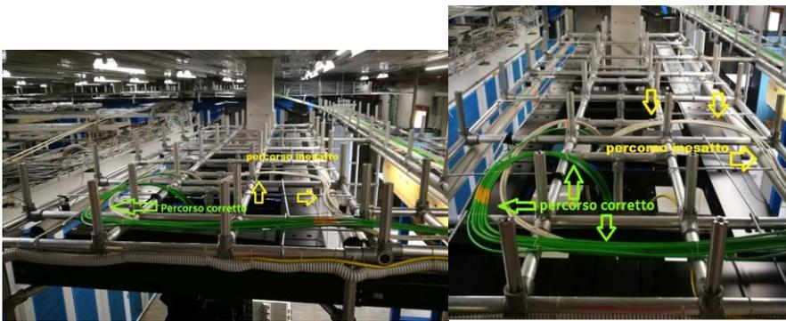
Figura 36 Esempio di posa cavo Breakout sul planare, percorso corretto (freccia verde)
