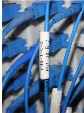
Esempio di Collegamento Figura 106 Es. Colleg.to Rip. Ottico—Apparato
