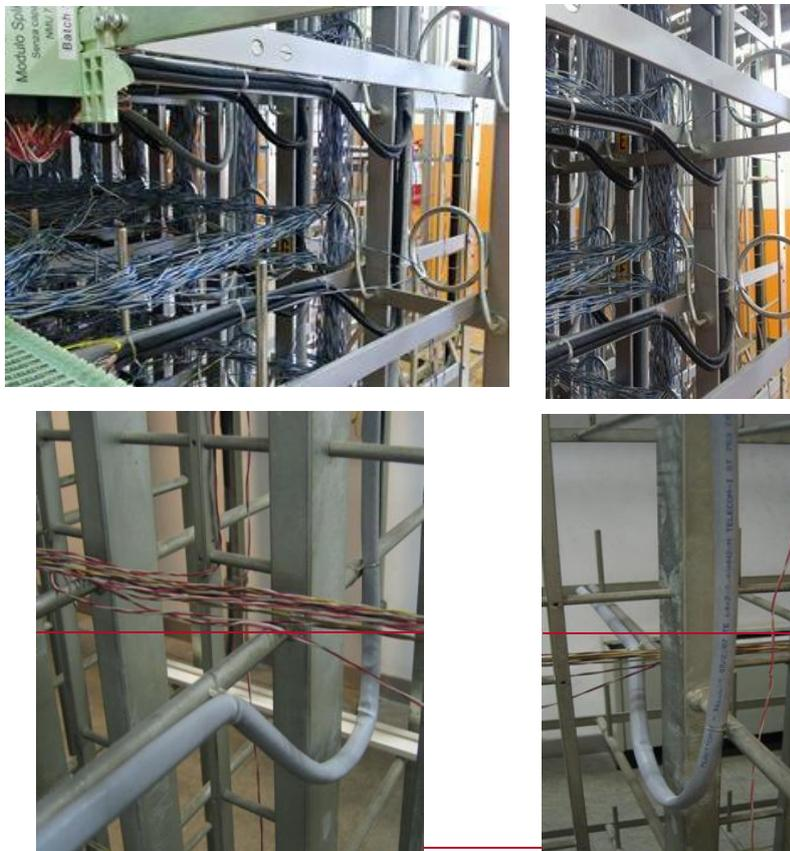
Figura ~~41:42~~ – Ricchezza del cavo sulla discesa al PU
