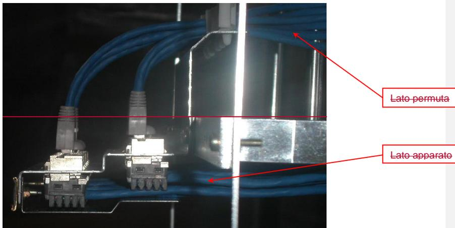
**Figura 58: Vista laterale del cablaggio della striscia orizzontale**
