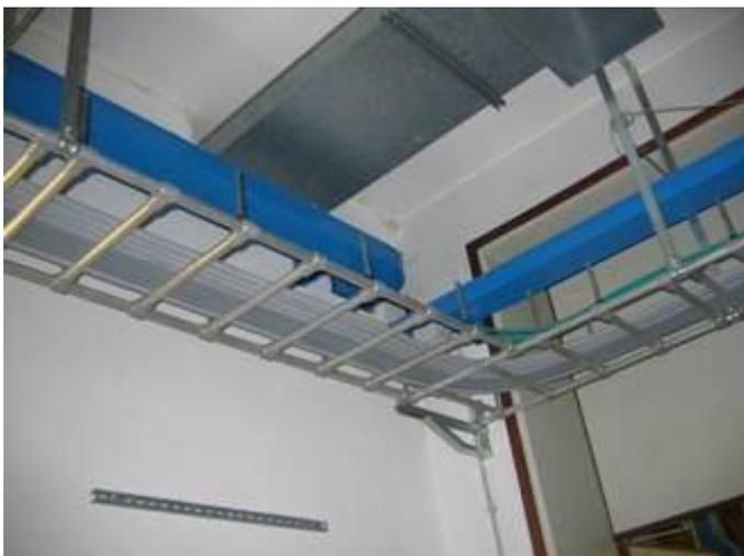
Figura 6 Passatoia doppia aperta orizzontale diametro 25 mm
