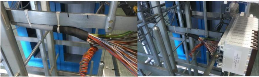
Figura ~~40:41~~ 40:41 \_ Esempio di legatura dei cavi BF sul lato orizzontale del Ripartitore Doppio FronteRip\_DF in prossimità della striscia di terminazione
