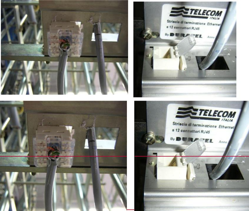
Figura ~~64-~~ Montaggio66 – montaggio connettore su supporto striscia
