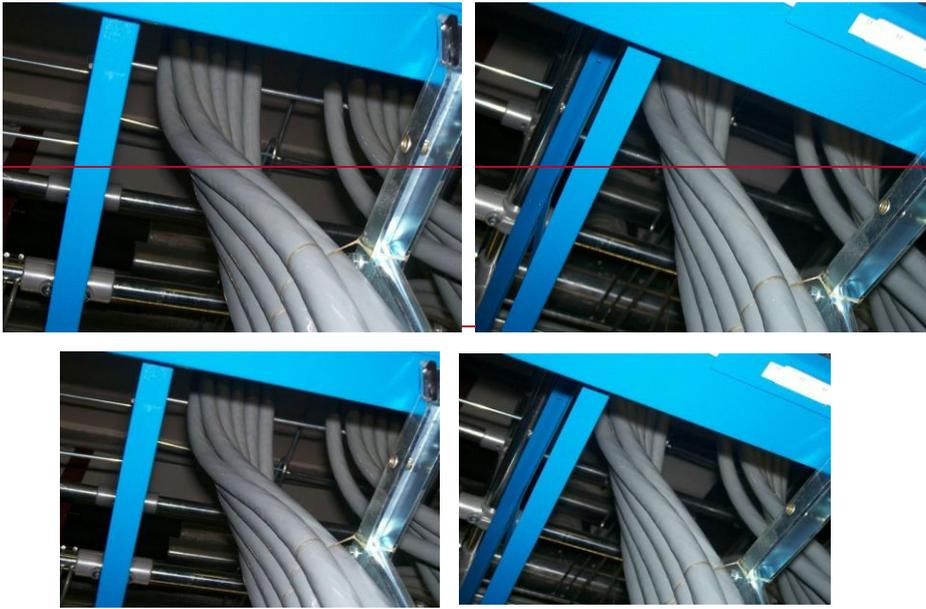
Figura ~~25-22~~ Esempio di posa dei cavi ~~ada~~ a elica
