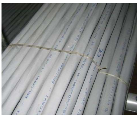
Figura 29 Dettaglio di legatura a “Fascio”
