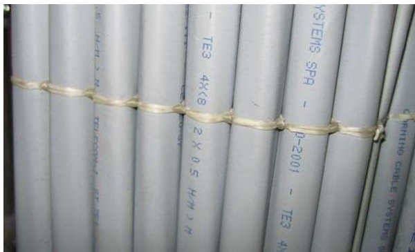
Figura 32 Dettaglio di legatura a "Pacco"
