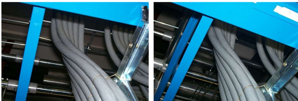
Figura 23 Esempio di posa dei cavi a elica
