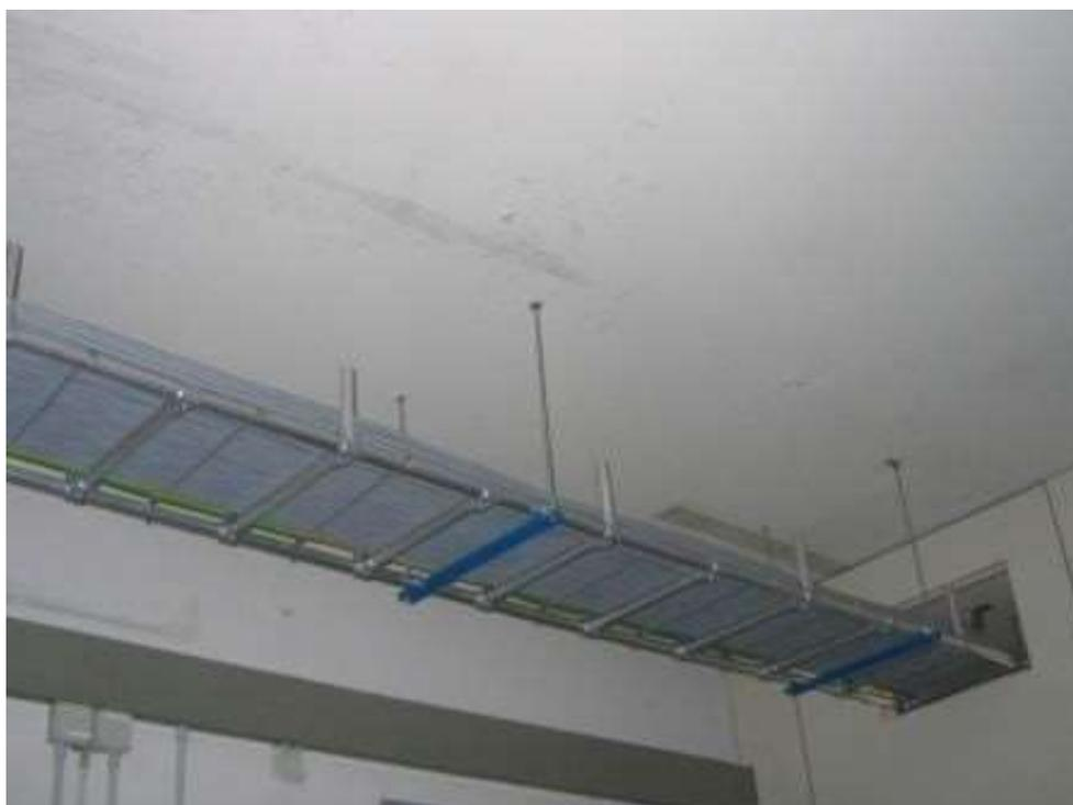
Figura 5 Passatoia Doppia aperta Tubolare Orizzontale diametro 35mm
