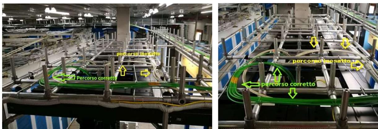
Figura 37 Esempio di posa cavo Breakout sul planare, percorso corretto (freccia verde)
