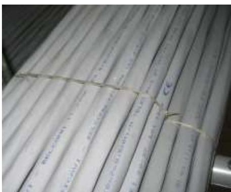
Figura 29 Dettaglio di legatura a “Fascio”
