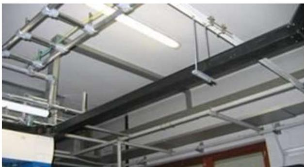
Figura 16 Canalina F.O. Interfila
