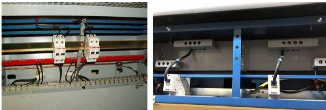
Figura 79 - Esempio di terminazione cavi unipolari su struttura di fila tipo ST81 (SX) e ST 2009 (DX)
