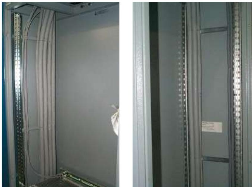
Figura 30 Legatura a “Fascio” interna alle fiancate del telaio
