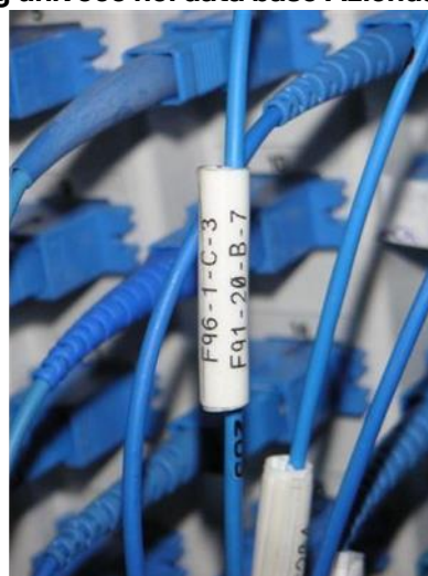
Figura 107 Es. di Colleg.to Rip Ottico-Rip
