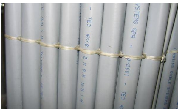
Figura 32 Dettaglio di legatura a "Pacco"
