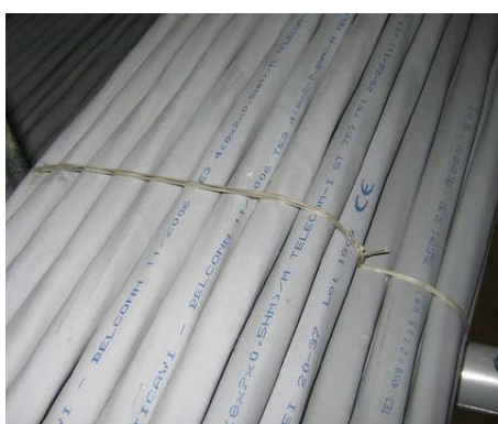
Figura 29 Dettaglio di legatura a "Fascio"
