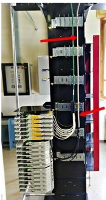
Figura 36 Discesa cavo Break-out su PO
