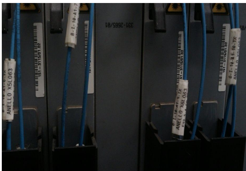
Figura 108 – Modalità di Etichettatura delle bretelle F.O.
