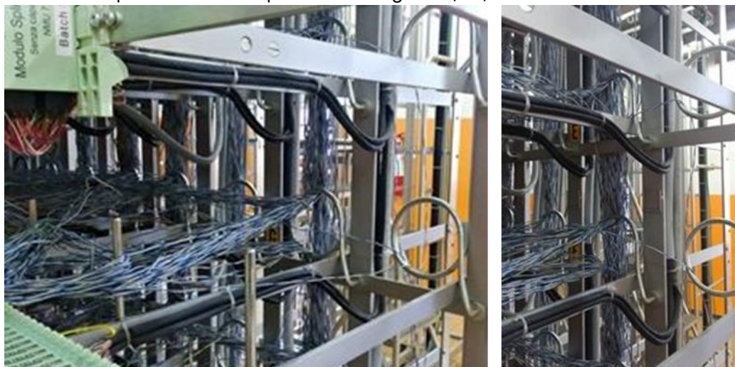
Figura 42 – Ricchezza del cavo sulla discesa al PU
