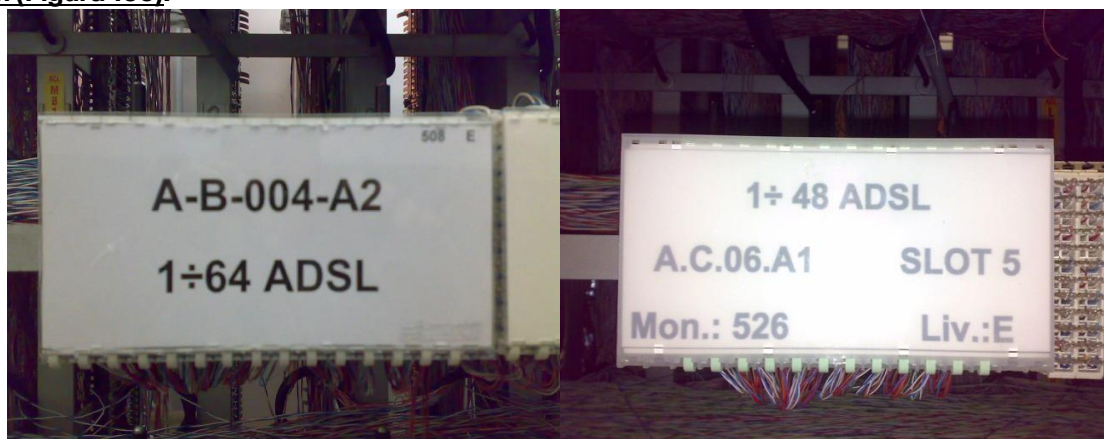
Figura 104 – Esempio di cartellini striscia per attestazione ADSL
