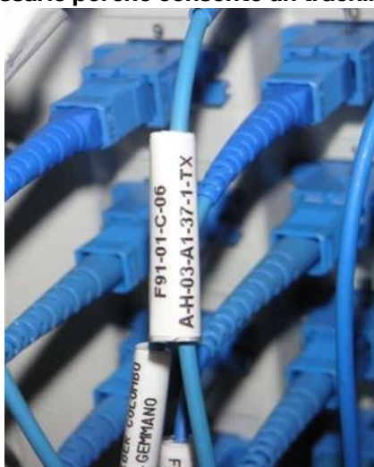
Figura 106 Es. Colleg.to Rip Ottico-Apparato
