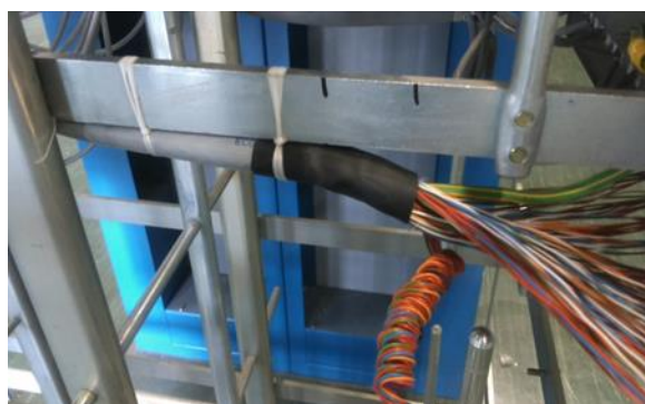
Figura 41 - Esempio di legatura dei cavi lato orizzontale del Rip DF in prossimità della striscia
