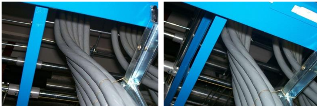
Figura 23 Esempio di posa dei cavi a elica
