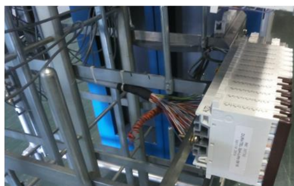
Figura 41 - Esempio di legatura dei cavi lato orizzontale del Rip DF in prossimità della striscia
