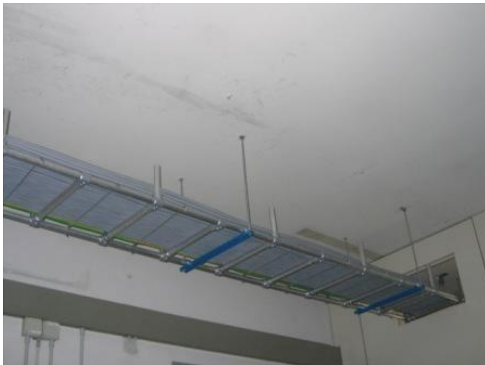
Figura 5 Passatoia Doppia aperta Tubolare Orizzontale diametro 35mm
