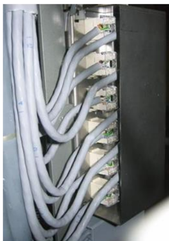
Figura 60 – Esempio di sagomatura cavi sul lato verticale
