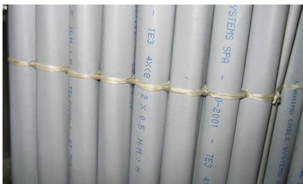
Figura 32 Dettaglio di legatura a "Pacco"
