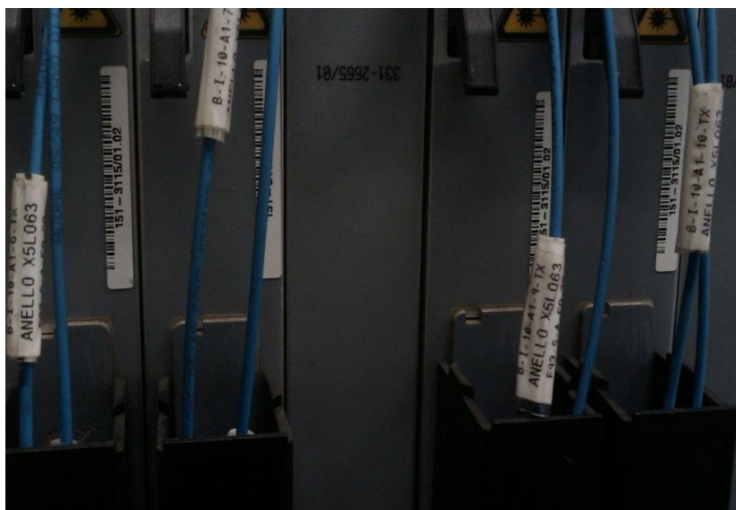
Figura 108 – Modalità di Etichettatura delle bretelle F.O.
