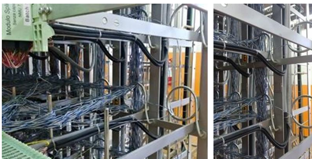
Figura 42 – Ricchezza del cavo sulla discesa al PU
