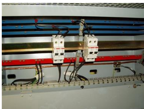
Figura 79 - Esempio di terminazione cavi unipolari su struttura di fila tipo ST81(SX) e ST 2009 (DX)
