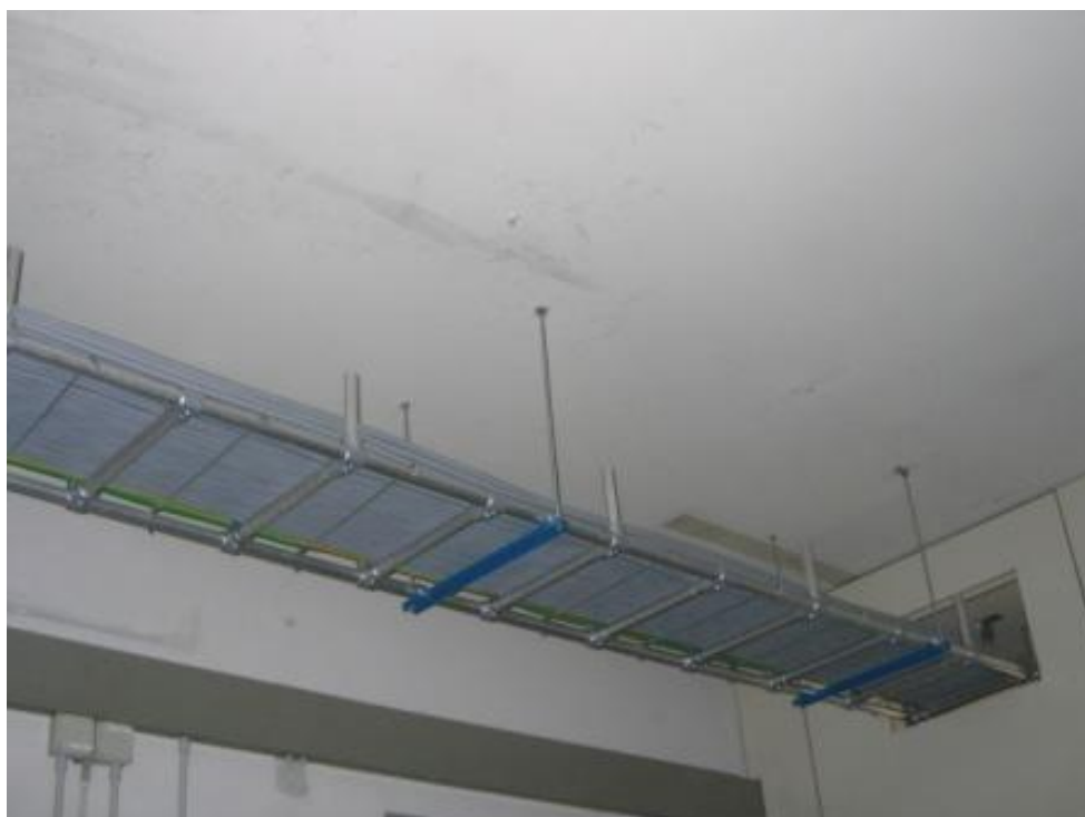
Figura 5 Passatoia Doppia aperta Tubolare Orizzontale diametro 35mm
