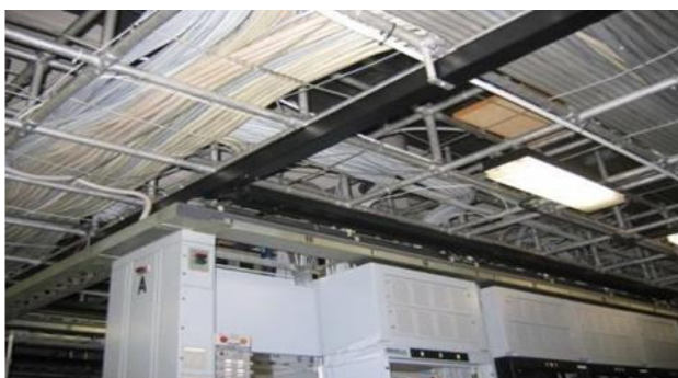
Figura 17 Canalina F.O. Interfila/Lungofila
