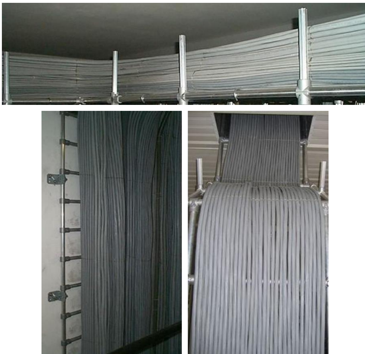
Figura 22 Esempio di posa orizzontale e verticale con pacco cavi omogeneo e compatto
