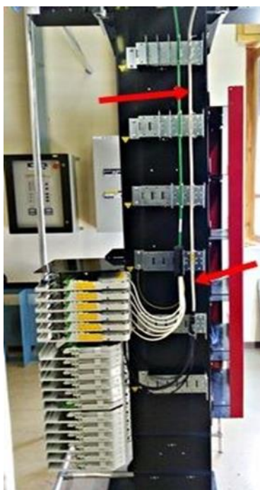
Figura 36 Discesa cavo Break-out su PO
