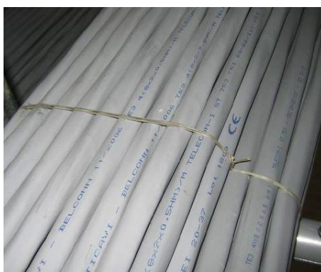
Figura 29 Dettaglio di legatura a "Fascio"
