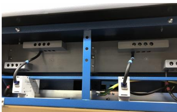
Figura 79 - Esempio di terminazione cavi unipolari su struttura di fila tipo ST81(SX) e ST 2009 (DX)
