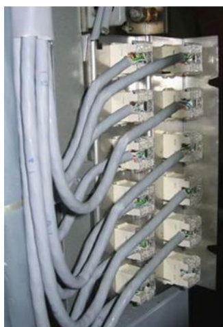
Figura 60 – Esempio di sagomatura cavi sul lato verticale
