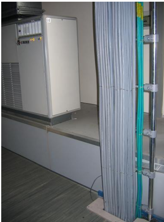
Figura 6 Passatoia Doppia aperta Tubolare Verticale diametro 35mm
