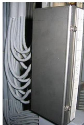
Figura 60 – Esempio di sagomatura cavi sul lato verticale
