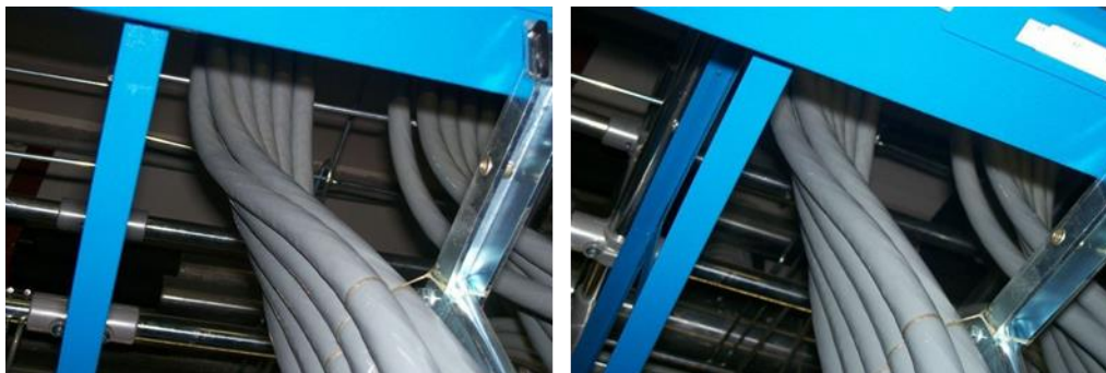
Figura 23 Esempio di posa dei cavi a elica
