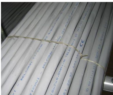
Figura 29 Dettaglio di legatura a “Fascio”
