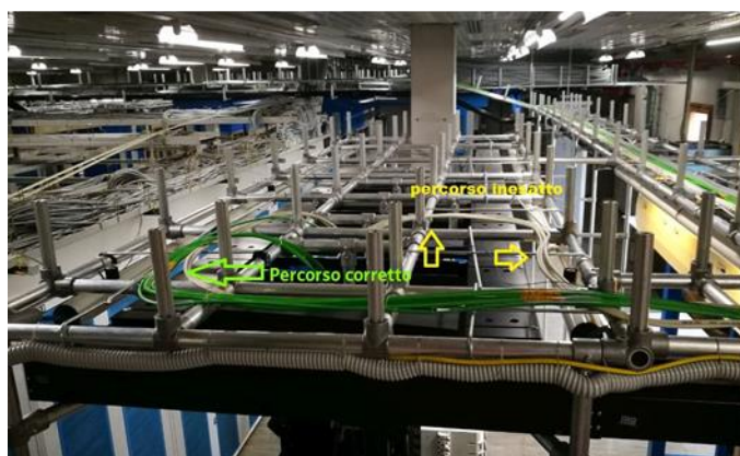
Figura 37 Esempio di posa cavo Breakout sul planare, percorso corretto (freccia verde)
