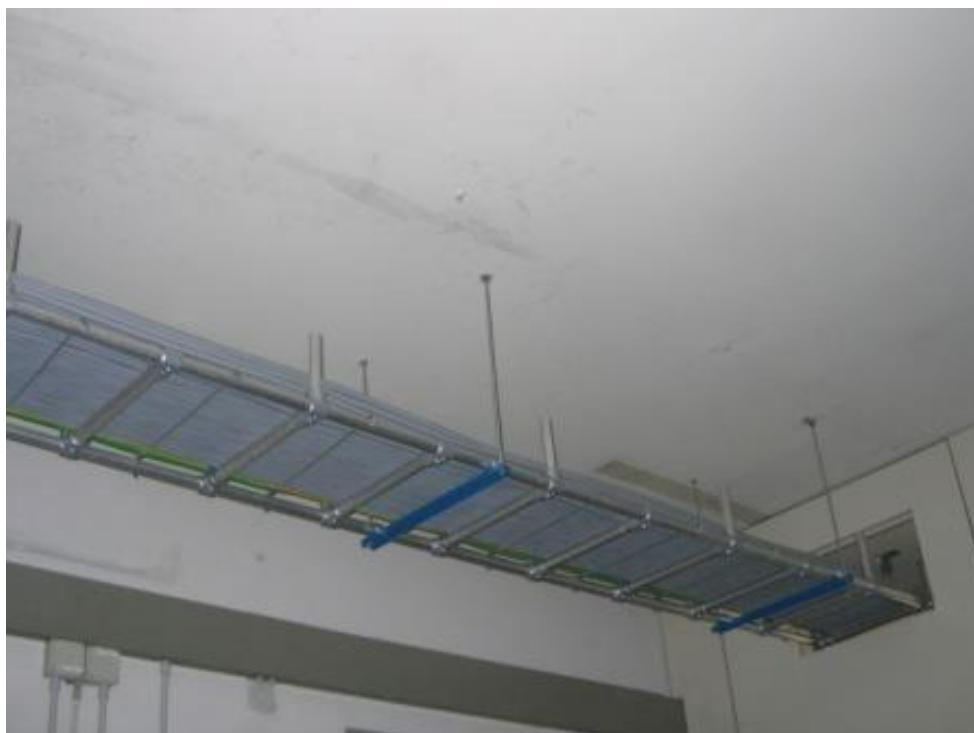
Figura 5 Passatoia Doppia aperta Tubolare Orizzontale diametro 35mm
