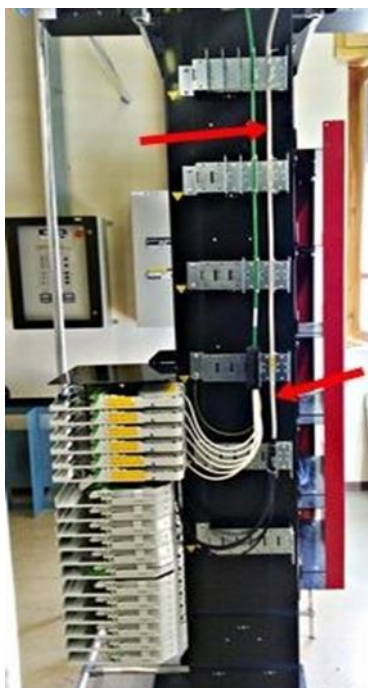
Figura 36 Discesa cavo Break-out su PO
