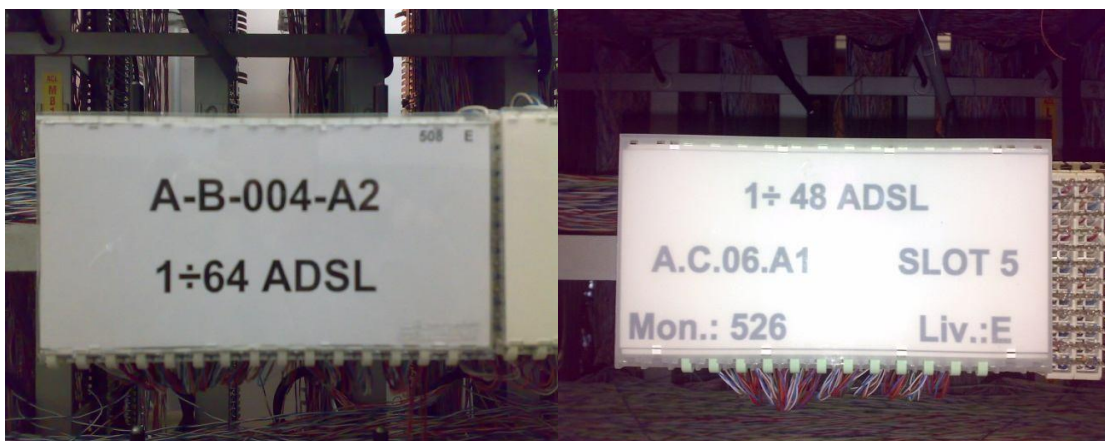
Figura 104 – Esempio di cartellini striscia per attestazione ADSL
