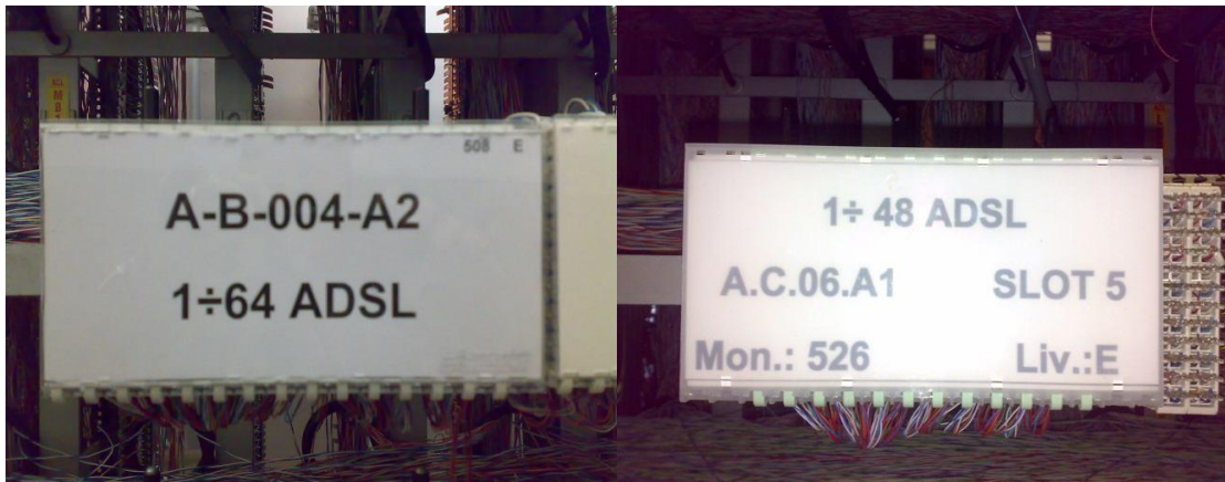
Figura 104A – Esempio di cartellini striscia per attestazione ADSL
