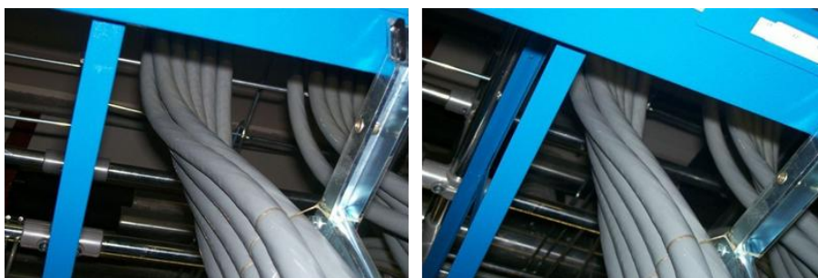
Figura 23A Esempio di posa dei cavi a elica
