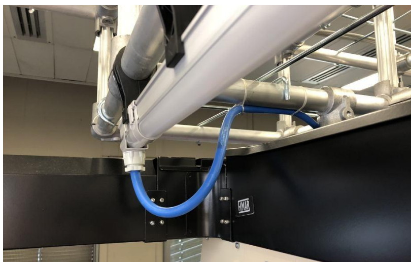
Figura 73A - Posa cavi di alimentazione doppio isolamento legato sotto il planare
