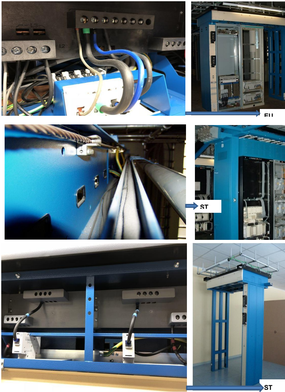
Figura 71A - Posa cavi di alimentazione su alcuni tipi di strutture di centrale
