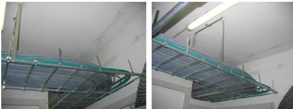
Figura 8A Passatoia doppia aperta in ferro
