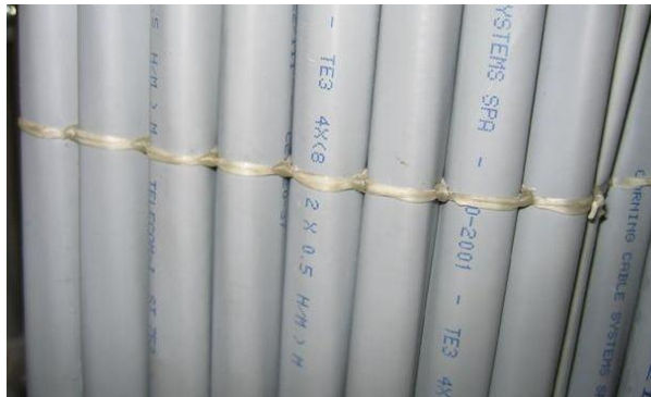
Figura 32A Dettaglio di legatura a "Pacco"
