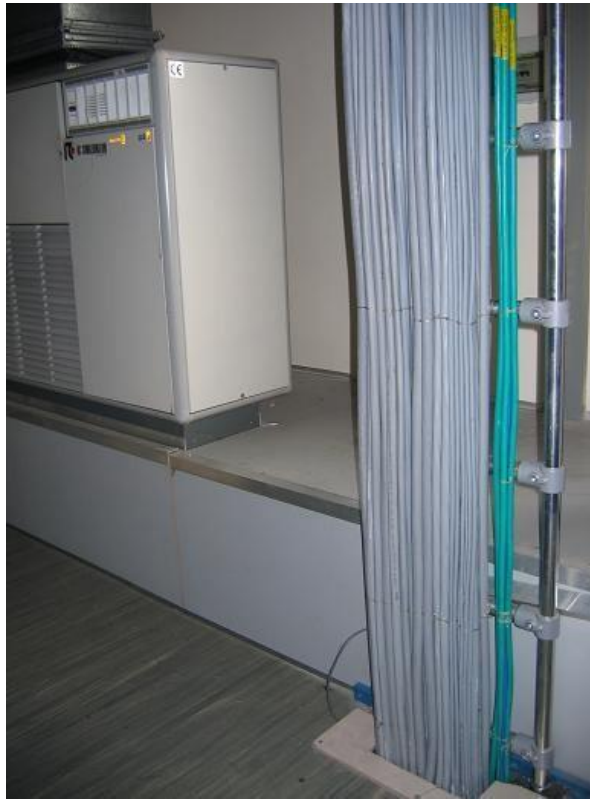
Figura 6A Passatoia Doppia aperta Tubolare Verticale diametro 35mm
