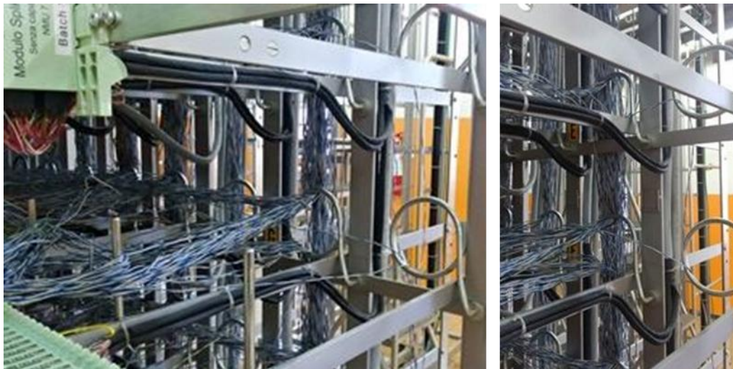
Figura 42A – Ricchezza del cavo sulla discesa al PU
