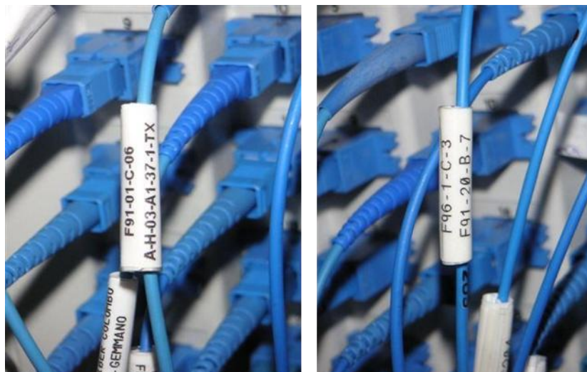
Figura 106A Es. Colleg.to Rip Ottico-Apparato Figura 107A Es. di Colleg.to Rip Ottico-Rip
