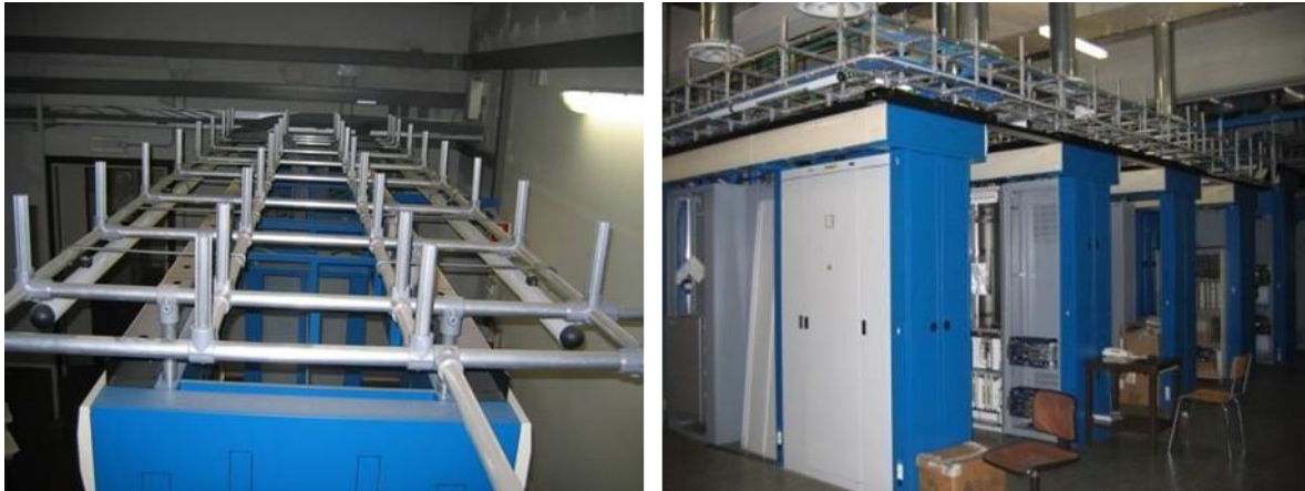
Figura 4A Planare tubolare da 35 mm ad un livello e a due livelli
