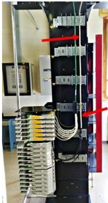
Figura 36A Discesa cavo Break-out su PO
